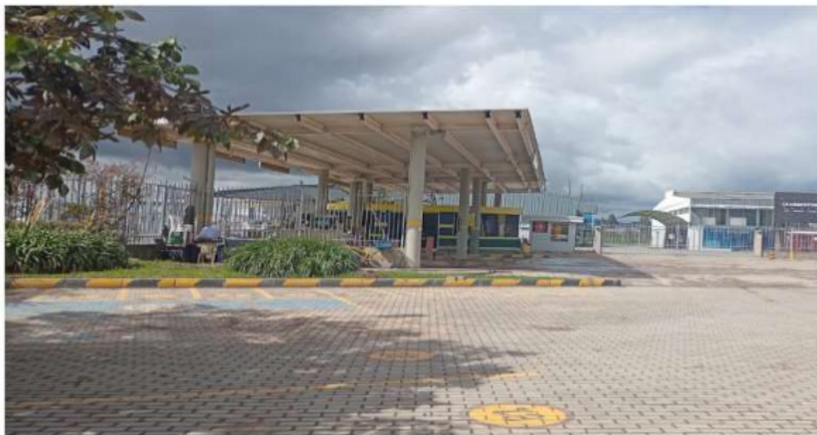
Ilustración 7 Punto de Control de Acceso al complejo Industrial
